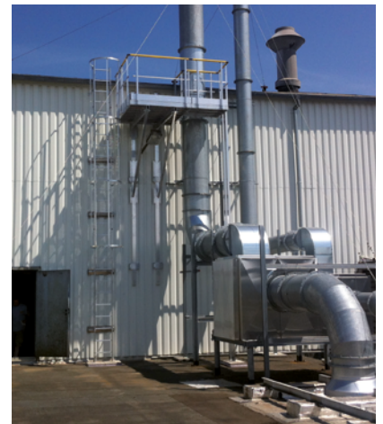
Échelle à crinoline et passerelle pour accès sur conduits d'extraction
