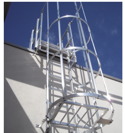
Accès en toiture et condamnation basse
