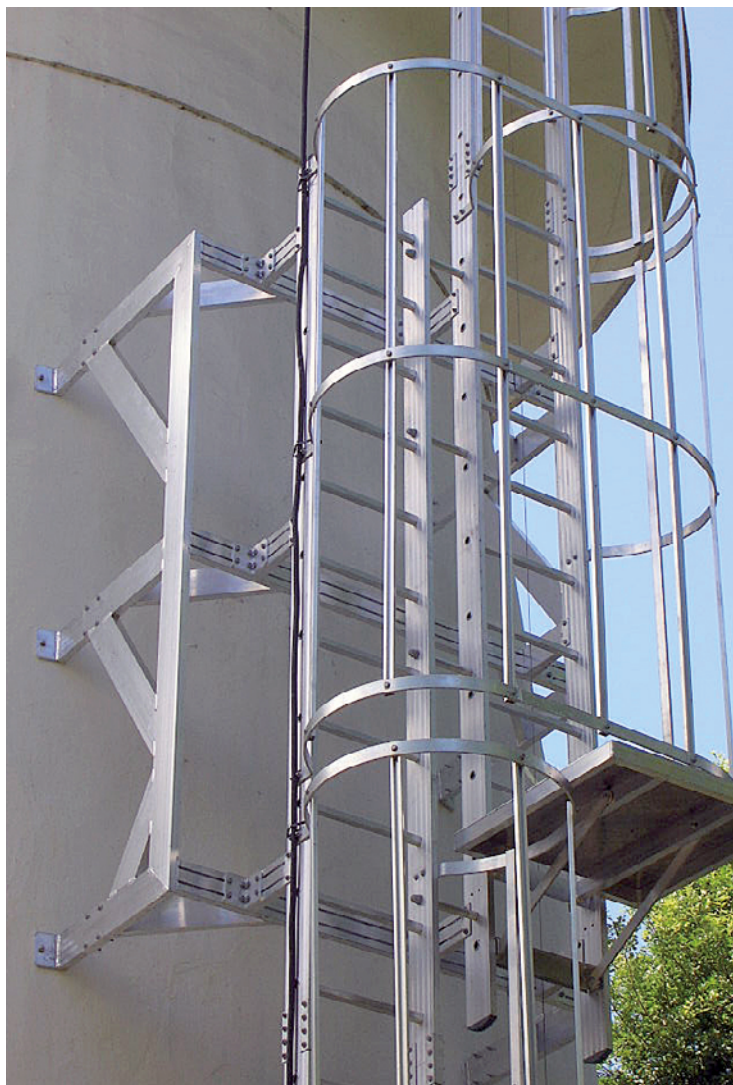
Échelle à crinoline montant renforcé pour accès en toiture d'un château d'eau
